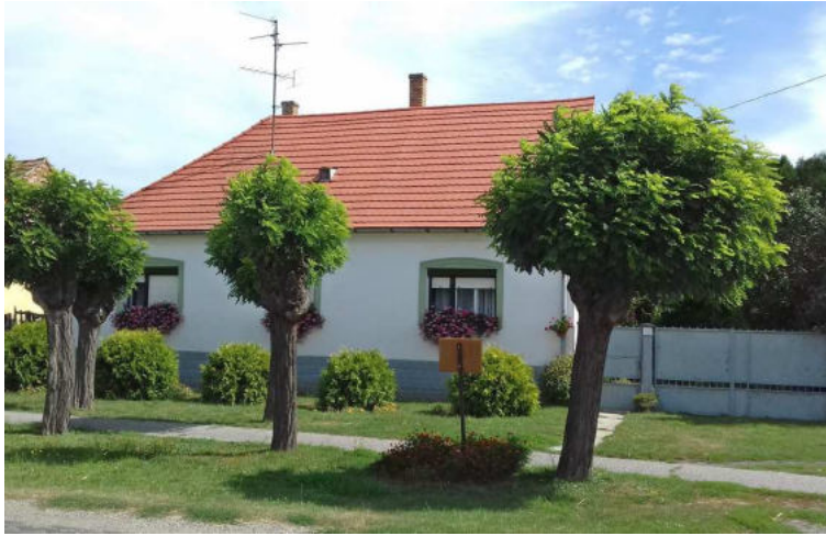
Város utca, példa értékűen felújított lakóépület
